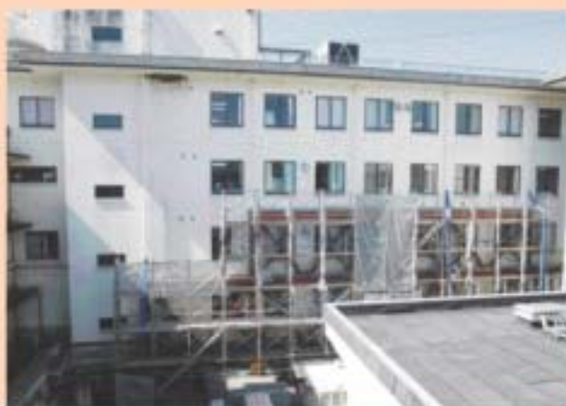
耐震工事中の中央館
